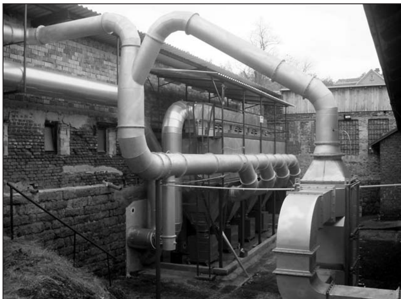
Obrázek 2: Filtrační stanice FVU v Horní huti, Lučany
